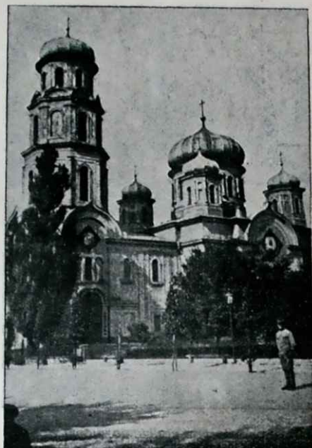
SOBÓR PRZED ROZBIÓRKĄ.
