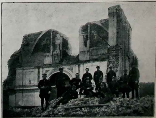
SOBÓR PODCZAS ROZBIÓRKI.
